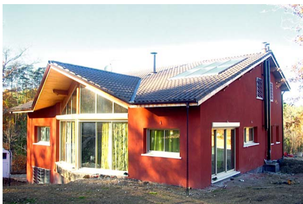
Рис. 2. Дом из монолитного костробетона
